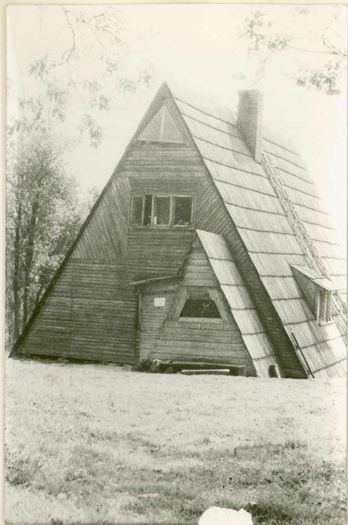
Fot. 1. Elewacja północna schroniska.
