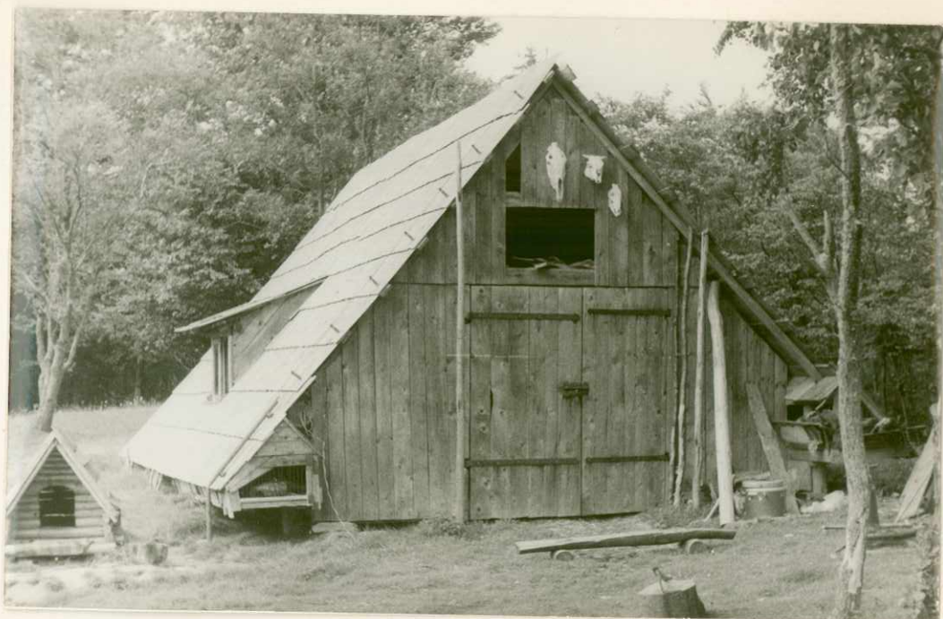
Fot. 5. Widok ogólny drewnutni od strony wschodniej.
