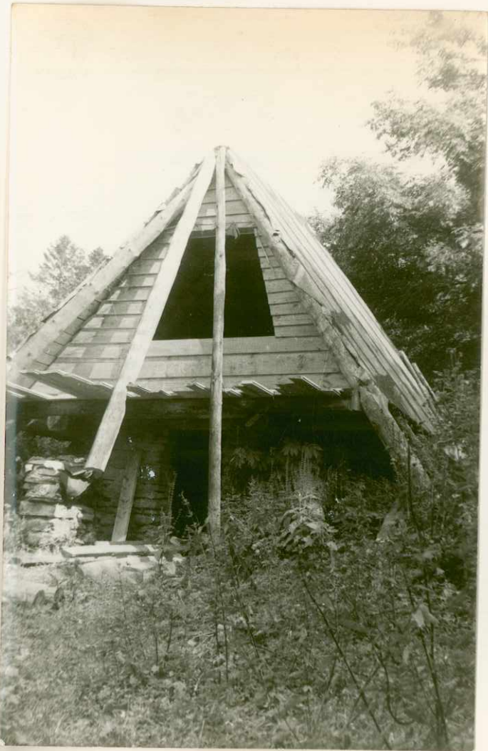
Fot. 8. Widok letniej chatki od strony północno-wschodniej.
