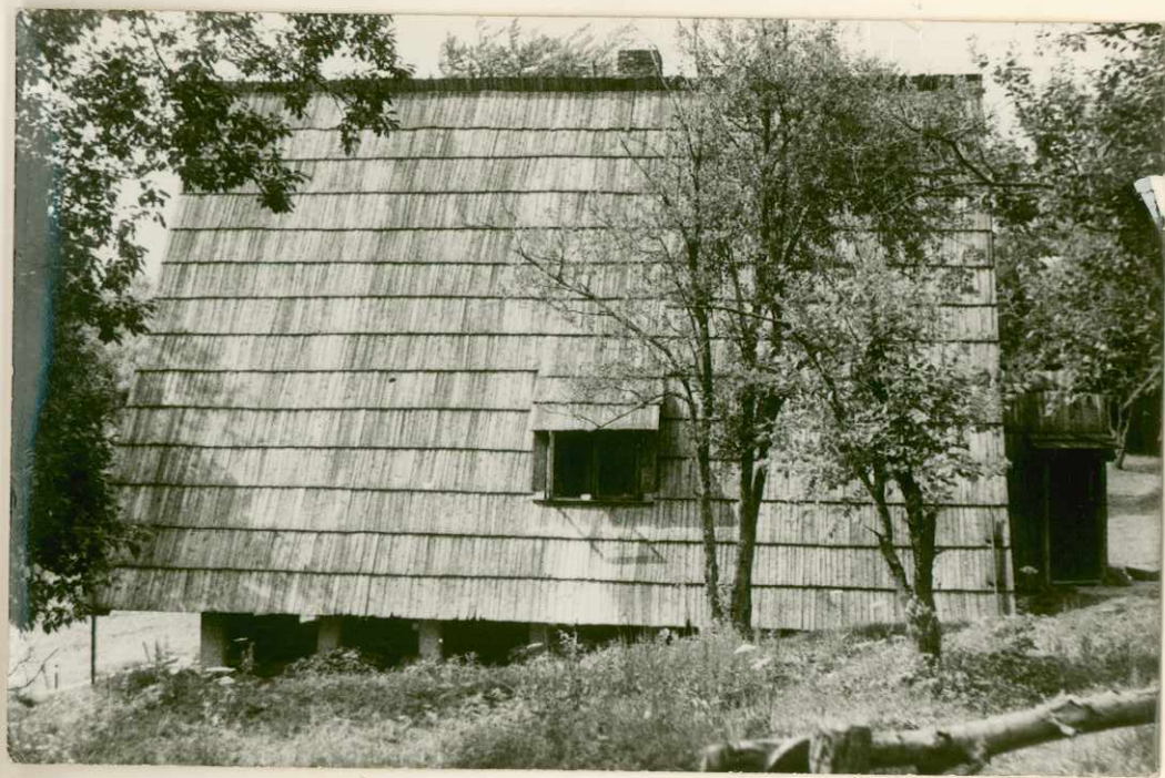
Fot. 2. Elewacja wschodnia schroniska.
